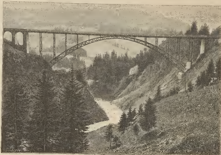
Fig. 3. - Puente sobre el valle del Javroz
